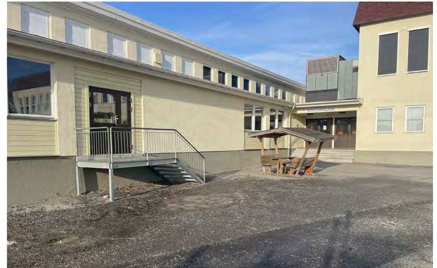
Flere av skolens innganger har kun trapper som adkomst til byggene.
