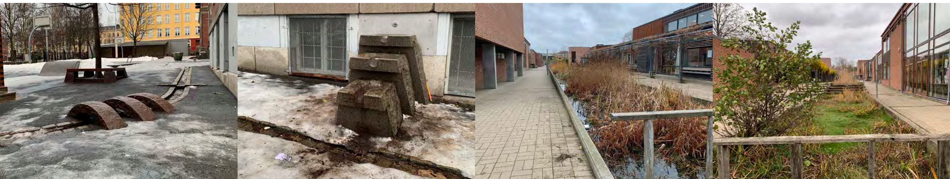
Grunerløkka skole, Oslo. Kreativ og robust utforming av vannrenner. Vannets vei er tilgjengelig for ulike typer lek.
