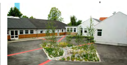
Brøndbyøster skole: Transformasjon av en liten asfaltert skolegård ved bruk av regnbed til både lek og overvannshåndtering.
