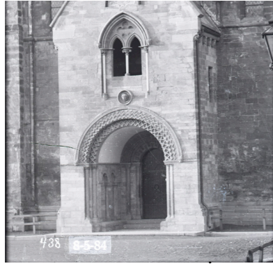
Figur 2.7 Ved siden av nordre inngang i tverrsipet kan man se jordfelter inngjerdet med tregjerder. Feltene er satt i kantstein. Dekket er ellers en form for grus eller jord. (© Nidaros Domkirkes Restaureringsarbeider, 1884)
