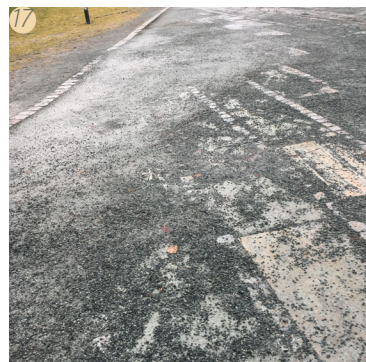
Figur 2.34 Ved en av adkomstene blir belegningssteinene tildekket av grus, og gangbanen utvider seg til plenarealet.
