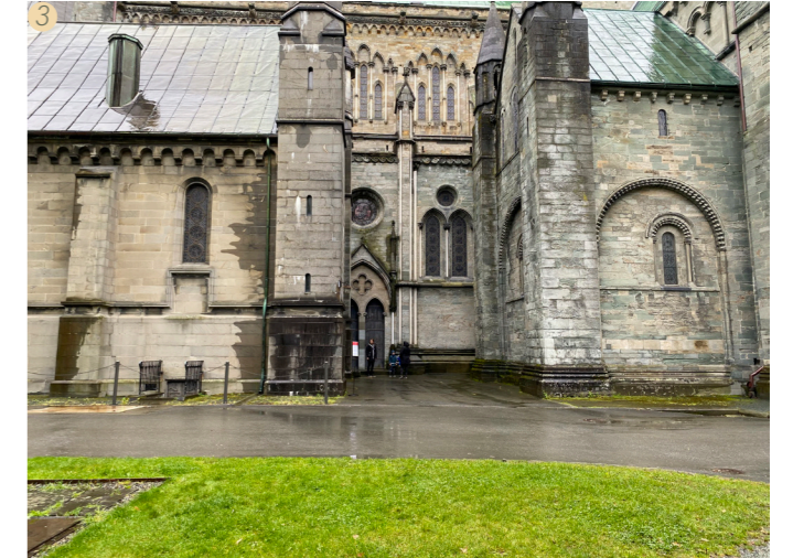
Figur 2.84 Smuget på nordsiden vekker nysgjerrighet hos de besøkende, og gir en følelse av at man er omsluttet av Domkirken
