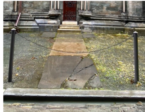
Figur 2.62 Grå sikringssperre i stål rundt Nidarosdomen
