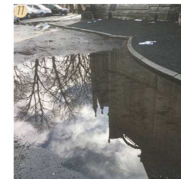
Figur 2.28 Større vanddammer samler seg på asfalten ved nedbør.
