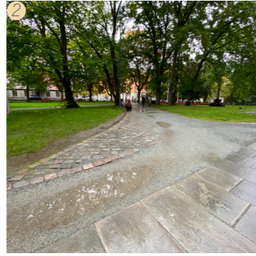
Figur 2.19 Plenen i ytterkant av gangstiene blir nedtråkket. Mellom feltene med belegningsstein blir grusen kompakt og vanddammer oppstår.
