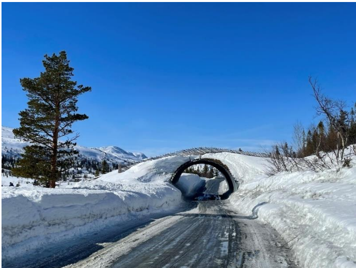
Figur 8: Planfri kryssing av vei som gir enkel tilgang til løypenettet på Gulsvikfjellet. Foto: Privat
