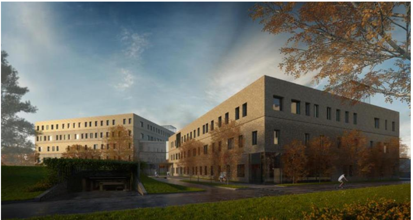
Figur 11: Oslo storbylegevakt (Oslo kommune, u.å-a)
