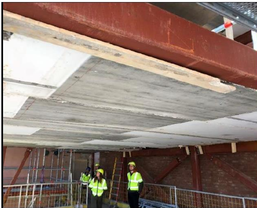
Figur 13: Ombrukte hulldekker i KA13. Foto: Rune Andresen (Nordby et al., 2021)
