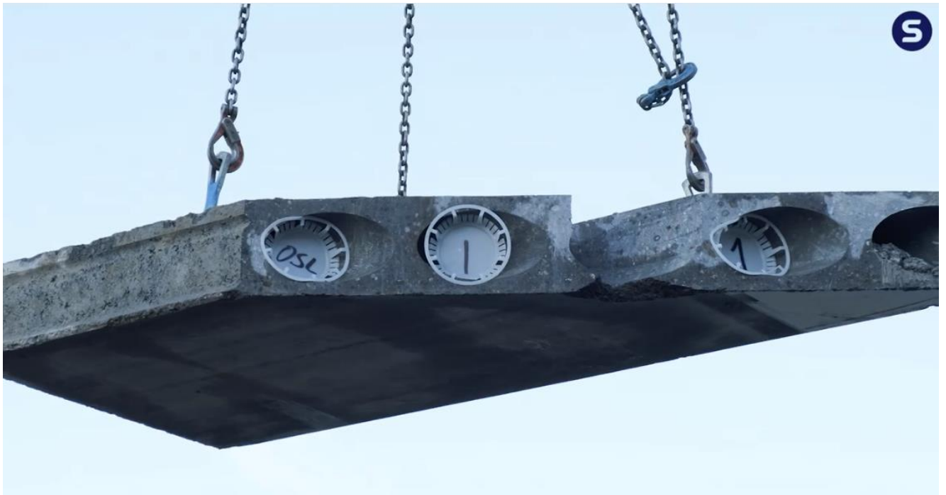
Figur 14: Ombrukshulldekkene i OSBL. Foto hentet fra Skanska AS
