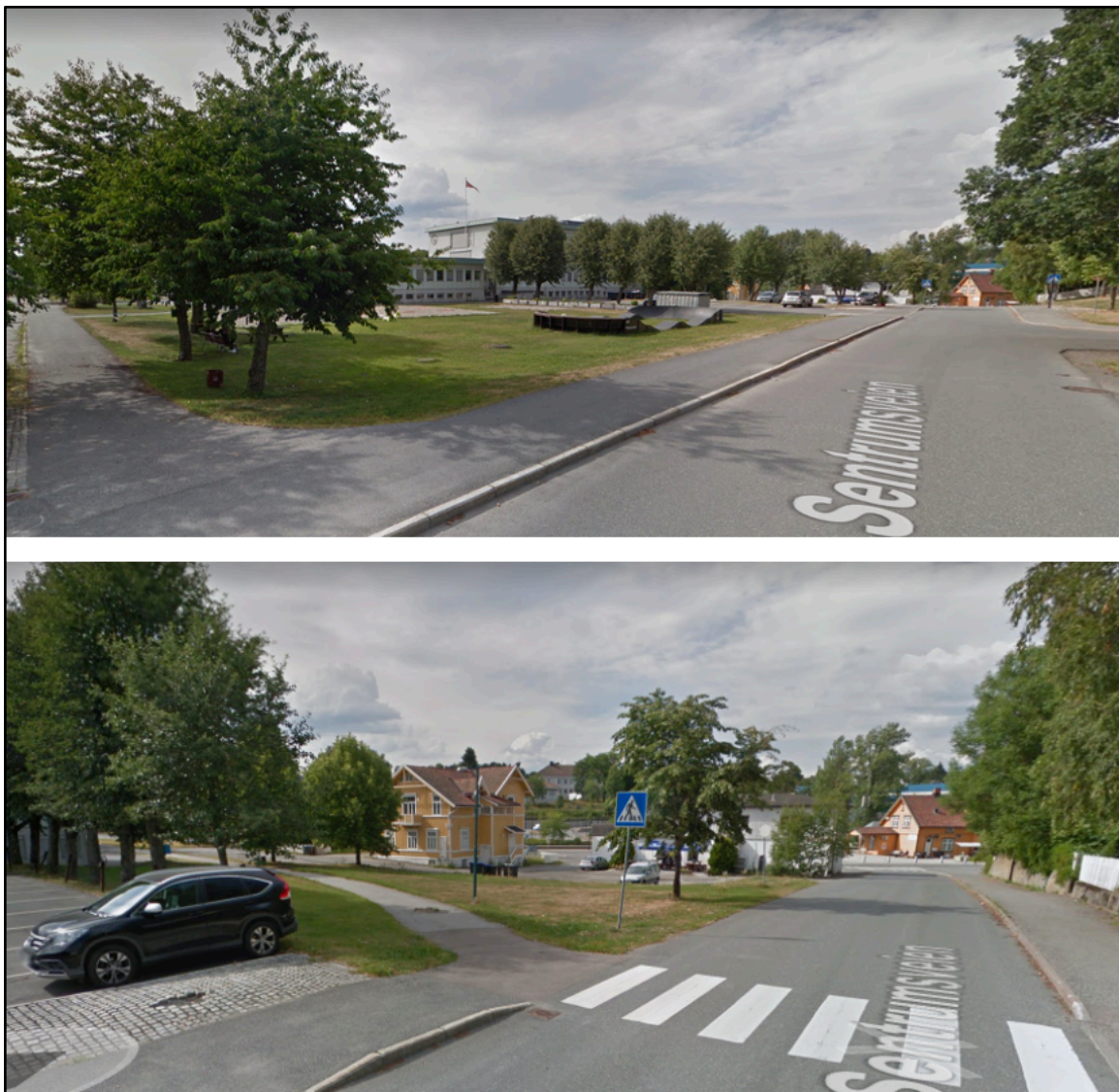
Figur 10: Oversikt transformasjonsområde. Kilde: google.com/maps
