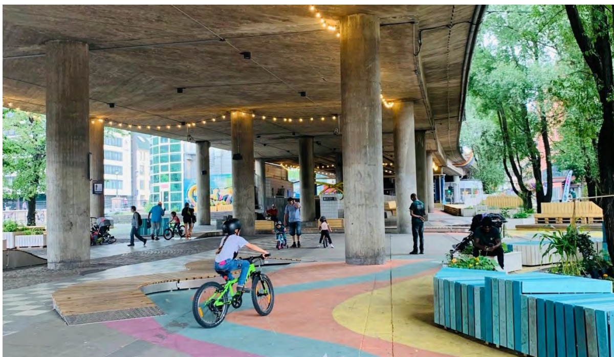
Figur 12. Olafia gangen etter testiltak sommeren 2021. Foto: Bymiljøetaten. (Klem, 2021).
