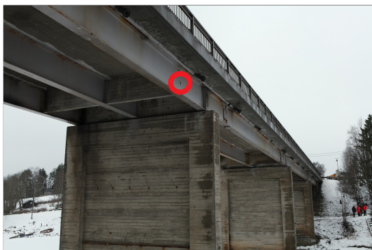
(a) Skråbilde med rustfleck i midten av bildet
