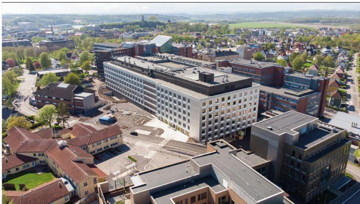
Figur 11: Bilde av nytt somatikk- og psykiatribygg, en del av sykehuset i Vestfold (Offergaard, 2021)
