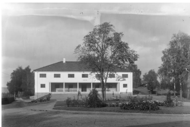
FIGUR 8: FOTO FRA 1934 VISER NY UTFORMING AV INNTUNET MED ET TUNTRE. I BAKGRUNNEN KAN DU SE DEN NYE GYMNASIUMBYGNINGEN SOM STOD FERDIG SAMME ÅR. AV UKJENT FOTOGRAF. KALNES LANDBRUKSSKOLE, BYGNING 1934, GYMNASIUMBYGNING. TRE BARN PÅ GÅRDSPLASS, FONTEN. SØYLEREKKEN. - ØSTFOLD FYLKES BILLEDARKIV / DIGITALTMUSEUM (CC BY-NC-ND)
