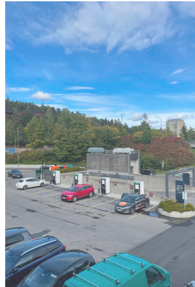
Asfalterte flater og terrengform
