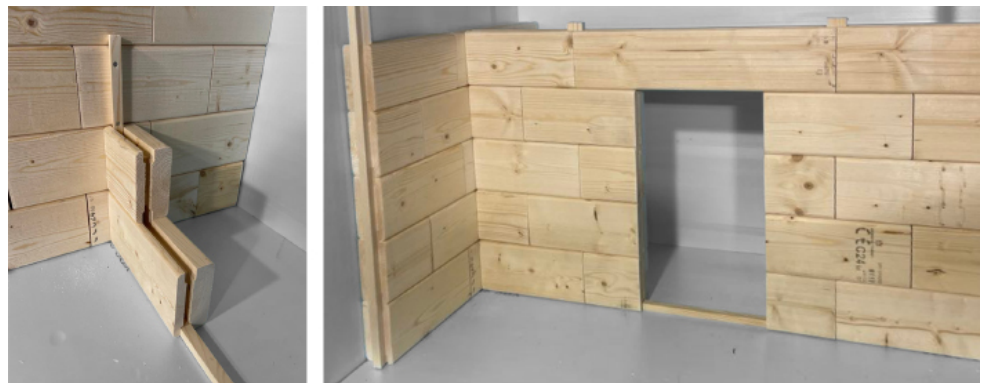
Figur 3-3. Modell av byggeblokkssystemet i målestokk 1:3 som demonstrerer overgang mellom vegger (venstre) og en veggåpning ment for en dør (høyre).
