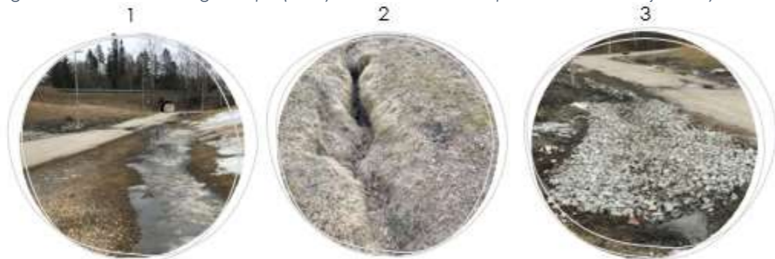
Figur 23. Bilder fra befaringsen i april (2022) bekrefter overvannsproblematikken i Skjettenbyen.
