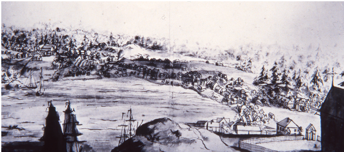
Figur: 3.9: Antakelig av M. Brumenthal. Kirka har ikke tårn og spir enda. I bakgrunnen mellom Herregården og kirka ser vi Steinhuset til Gyldenløve.
