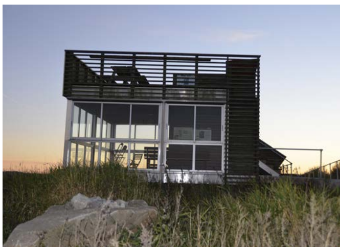
Fugletårnet på Øraspissen ble bygget i 2003 og er tegnet av Griff arkitektur i forbindelse med en konkurranse i 1995.
