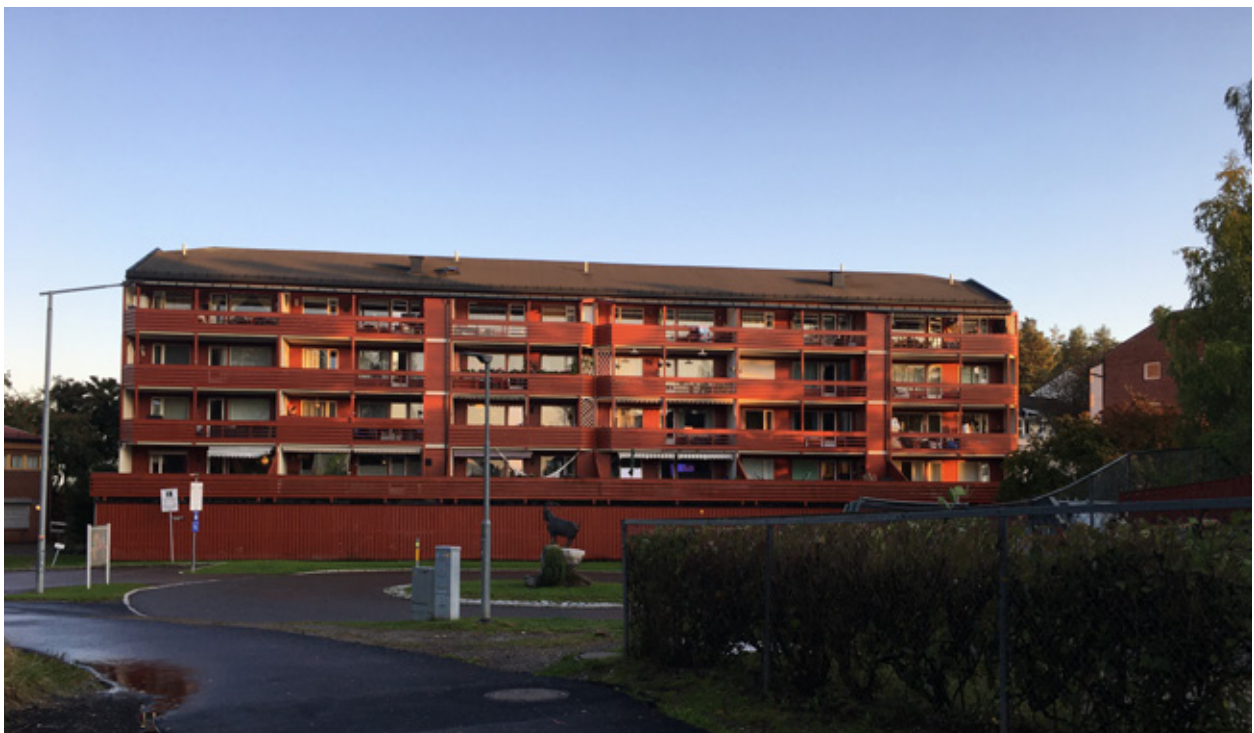
Figur 7. 12. Bebyggelse i området deltakerne bor i. Blokken har beholdt sin opprinnelige rød farge.
