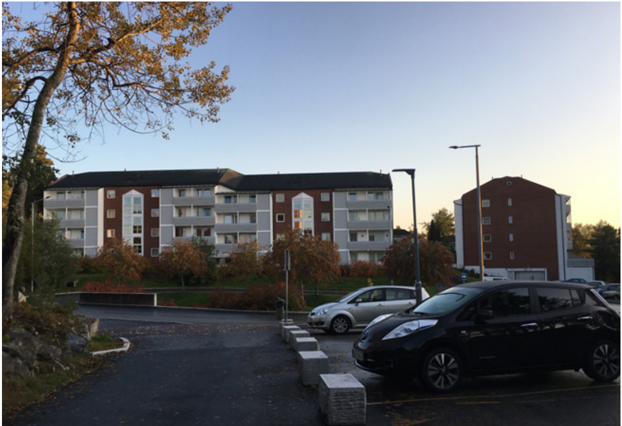
Figur 7. 9. Bebyggelse i området deltakerne bor i. Mursteinsblokkenes trekledning på fasadene har blitt endret fra rødt til grått og hvitt.
