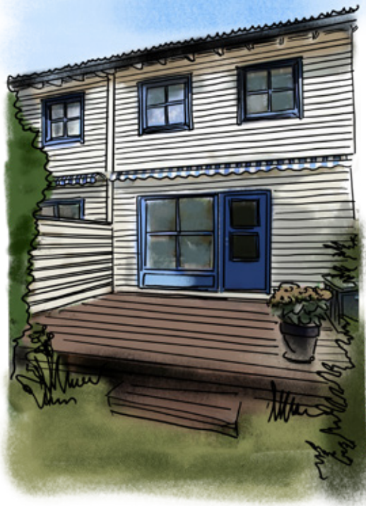
Figur 7. 15. Gamlelinja borettslag på Holmlia. Hvite vegger og blå kontraster. Bygget på 1980-tallet.
