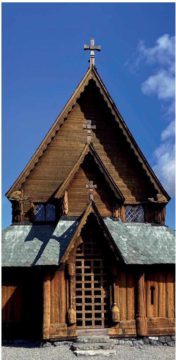
Reinli stavkirke. Vestfasade.. Foto: Ebert 2020
