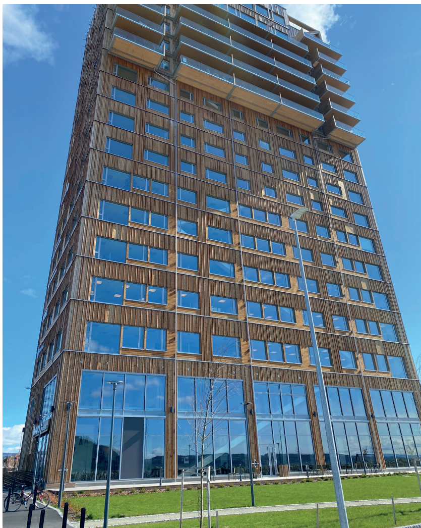
Bildet viser Mjøstårnet med balkonger ut mot sørvest og Mjøsa. Bak glasset skimtes de store skråavstiverne. Foto: Houck
