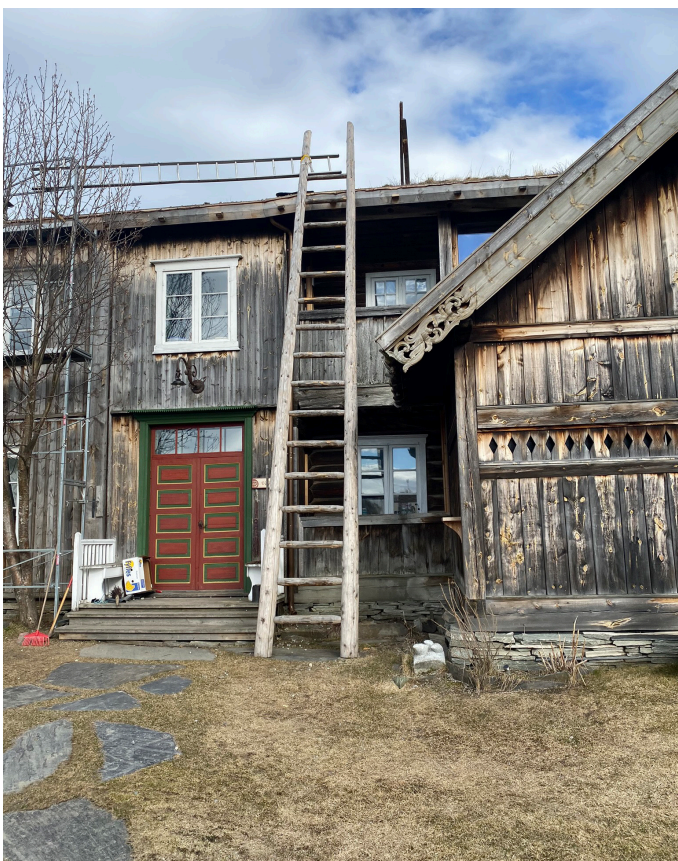
Kleppe gård med brannstige opp til taket av hovedbygningen. Foto: Houck 2020
