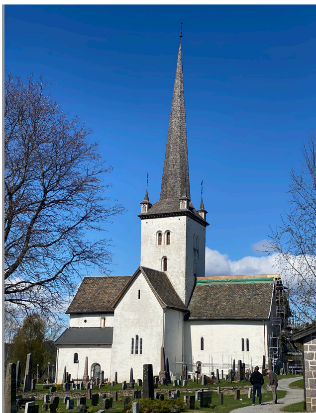
Ringsaker kirke. Kalksteinsmur med kalkmaling. Foto: Houck 2020
