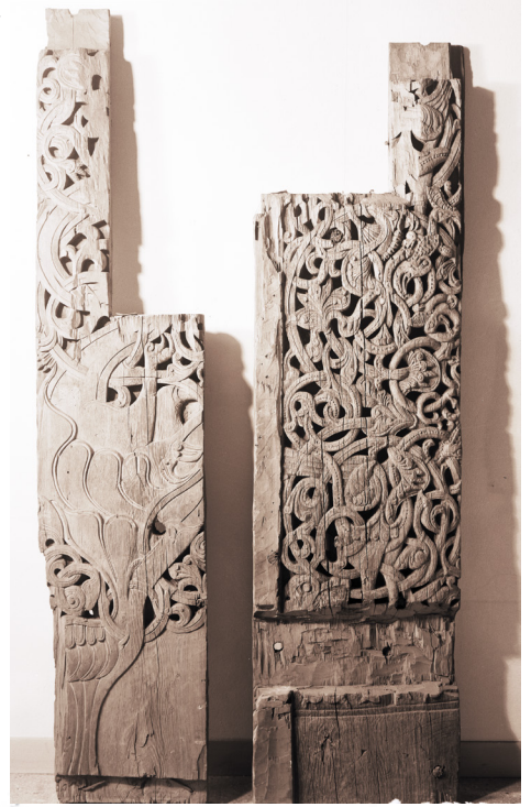
Hegge stavkirke. Restene av portalen. Bilde: Ukjent, Riskantikvaren
