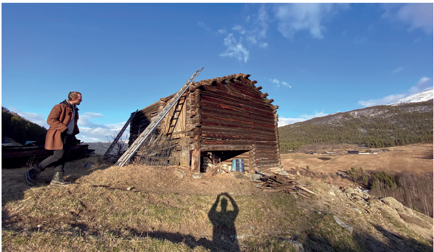
Heidal. Denne løa er solgt, og skal demonteres og bringes til Østerdalen.
