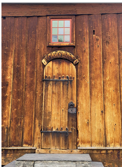
Lom stavkirke. Hovedinngangen. Panelene har store dimensjoner, vi måler dem til å være 49-52 cm brede. Foto: Houck 2020
