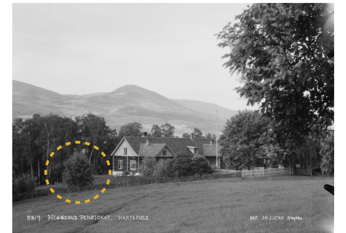
Figur 2.24. Fotografii tatt fra brønnen mot hovedhuset
