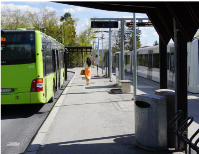
Figur 65: Stasjonens nordlige plattform har en dobbel funksjon og fungerer også som bussholdeplass.
