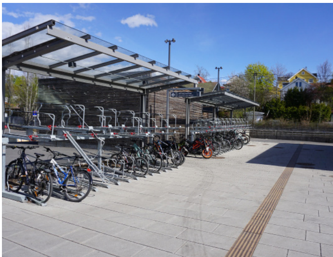
Figur 42: Sykkelparkering i to-etasjes stativer med tak. Parkeringen blir mye brukt, men få bruker andreetasjen.
