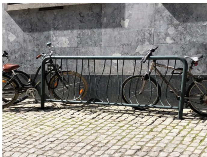
Figur 9: I dette sykkelstativet i Trondheim er man ment å sette dekket inn i stativet, men siden stativet hverken gir nok støtte eller gode nok låsemuligheter så har brukerne funnet en annen låsemetode.
