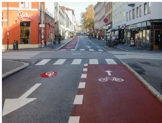
Figur 7: Motstrøms sykkelveg i Markveien på Grünerløkka i Oslo. Her er veien enveiskjørt for bilister mens du kan sykle i begge retninger som syklist. En slik løsning er med på å øke framkommeligheten for syklister samtidig som det er arealeffektivt og minsker framkommeligheten for bilistene. Foto: Oslo kommune
