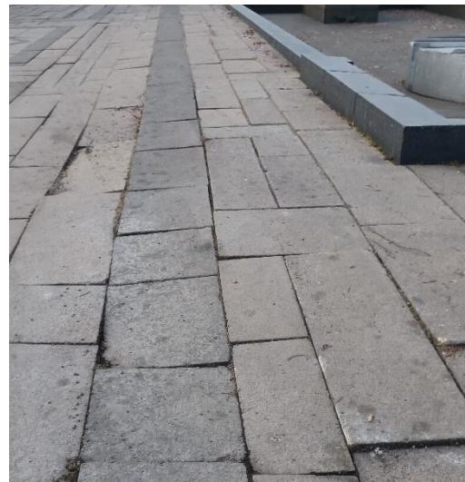
Figur 20 Setning i dekket langs fonteneanlegg. Foto: Stian Lilletveit (2022, mars 11)
