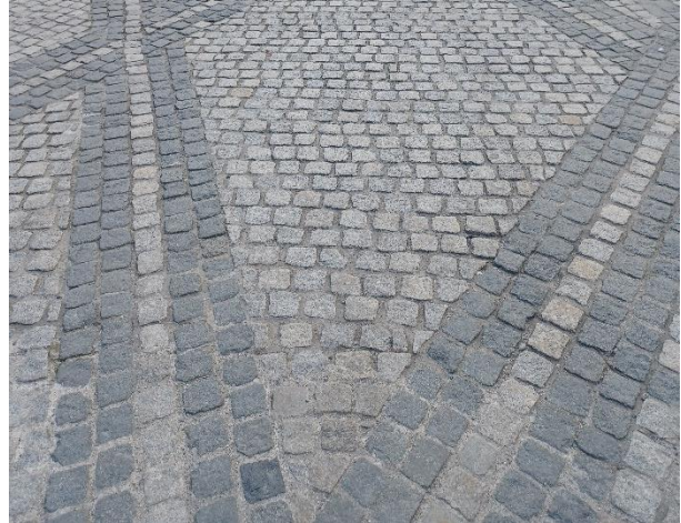
Figur 1 Granittbelegning satt bundet. Det vil si et steindekke med betong som sette- og fugematerialet. Inngangsparti til Rådhuset i Oslo. Foto: Stian Lilletveit (2022, mars 11)
