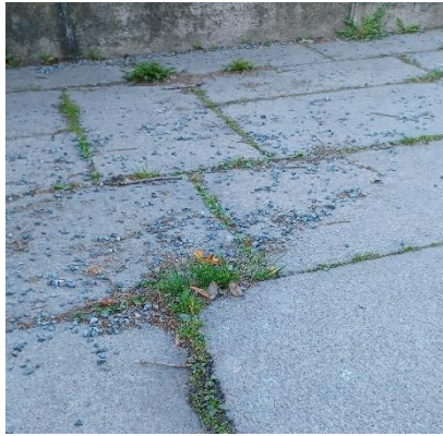
Figur 17 Ugress i fugene, og løvetann vokser opp muren. Foto: Stian Lilletveit (2022, april 30)
