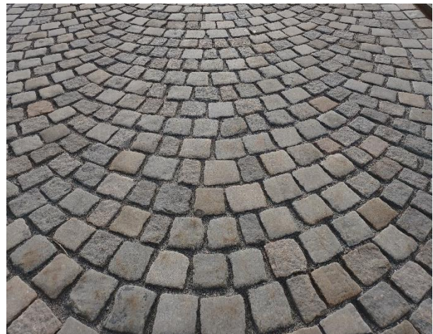
Figur 2 Brosteinbelegning satt ubundet. Bildet viser råhogd granittsteiner satt i knas, med løsmasser som sette- og fugematerialet. Kaia på Rådhusplassen. Foto: Stian Lilletveit (2022, mars 11)
