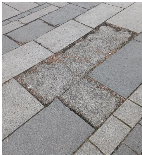
Figur 21 Lappeteppe av betong på granittdekke. Foto: Stian Lilletveit (2022, mars 11)
