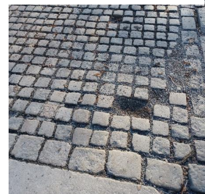
Figur 13 Smågatestein mangler i dekke. Foto: Stian Lilletveit (2022, mars 11)
