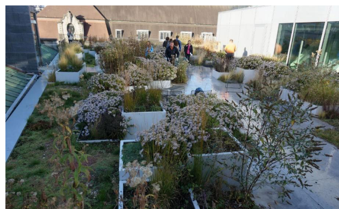
Figur 2.8 Grønt tak på et kontorbygg i Amsterdam (NIVA rapport nr 17283, 2019, s. 22)
