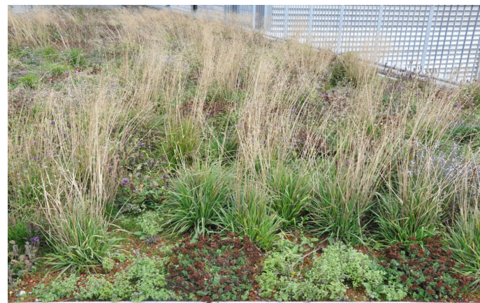
Figur 2.3 Eksempel på et semi-intensivt tak. Vegetasjonen består av gressarter og stauder (Noreng et al., 2012, s. 42)
