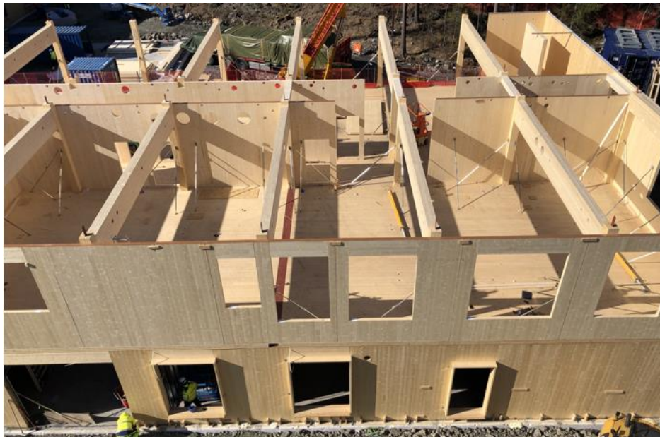
Figur 16. Bildet viser Bamble Ungdomsskole under bygging. Både vegger og dekker er i massivtre, og elementene heises på plass med ferdige utsparinger til åpninger og tekniske føringer. Foto: Backe Vestfold Telemark AS og Spinn Arkitekter AS v/ James Dodson
