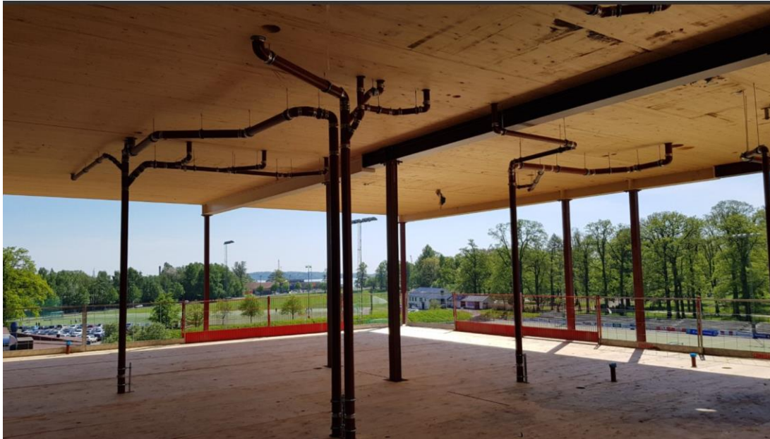
Figur 17. Bildet viser Horten VGS i råbyggfasen med ferdige utsparinger til teknisk utstyr og montert rørsystem før veggene er oppe. Foto: Tom André Gustavsen// Gran VVS AS.
