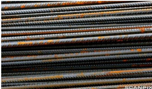
Figur 5. «Overflatebehandling og korrosjon: Armeringsjern med striper av rust», av Erichsen, J. F., NTB scanpix. ( https://ndla.no/article/9569 ). CC BY-NC-SA 4.0.
