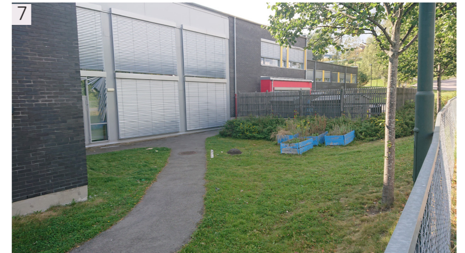
Figur 2.8: Østsiden av skolebygget har en smal asfaltvei som leder til skolens søppelkonteinere.
