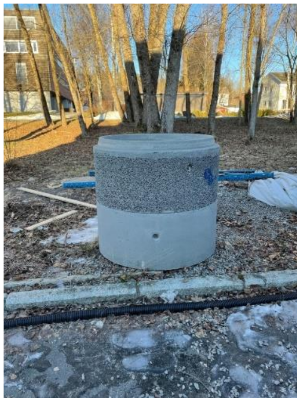
Figur 10: Bilde av permeabel kumring satt ut for frostforsøk på NMBU. Tatt av Eirik S. Bråten 20.01.2022.
