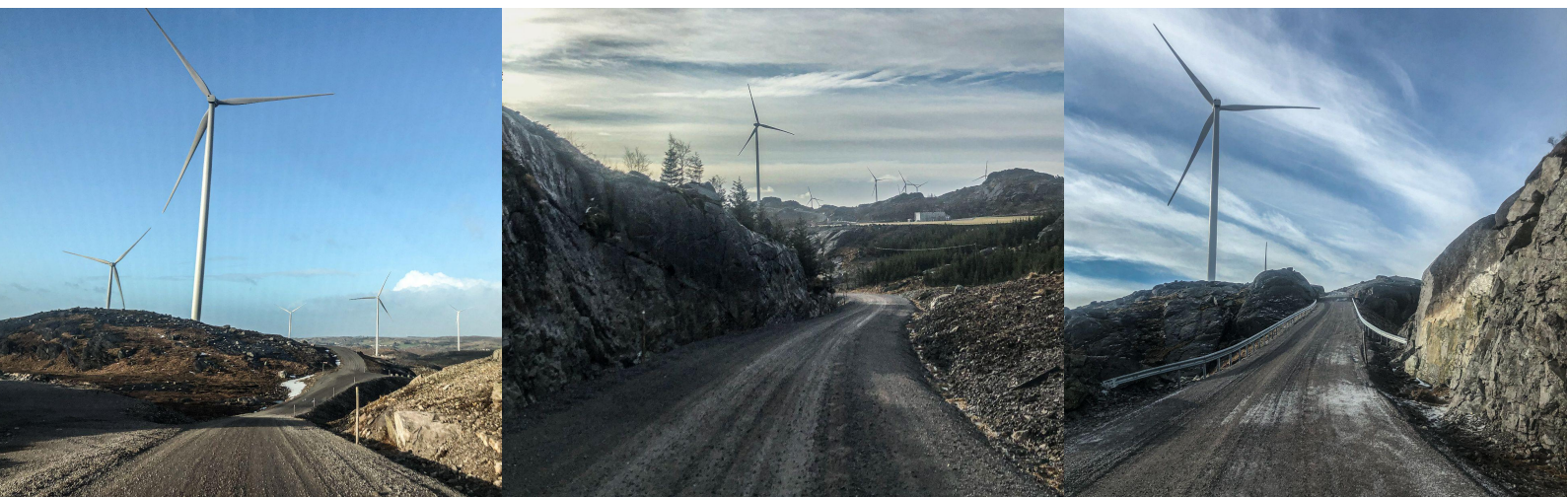
Figur 35: Til venstre er en relativt skånsom veifylling som i større grad følger landskapet enn de to påfølgende bildene hvor det er store inngrep med fylling og sprengning. Foto: Privat.
