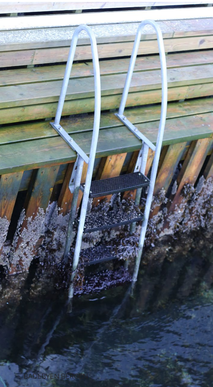
Børstet stål med dype plasttrinn. Laksevåg Bibliotek.
