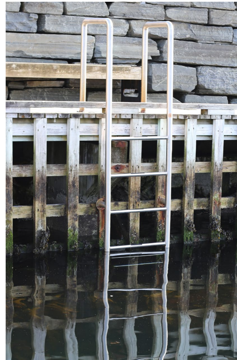
Stål med antiskli-stripe på smale, runde trinn. Verftet.
