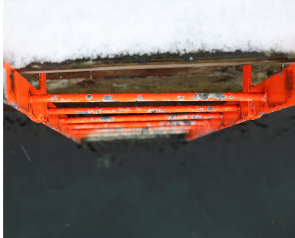
Lakkert stål med smale, runde trinn i signaloransje. Sandviksbodene.
