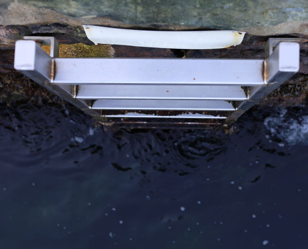
Stål med kantede trinn, ikke lakkert eller børstet. Ballastbryggen.
