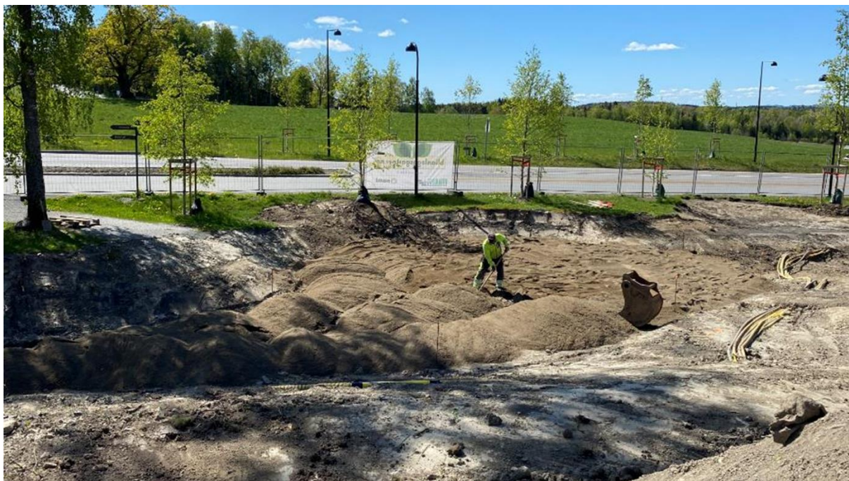
Figur 6: Utleggelse av drensaget. Foto: Jorun Hovind
