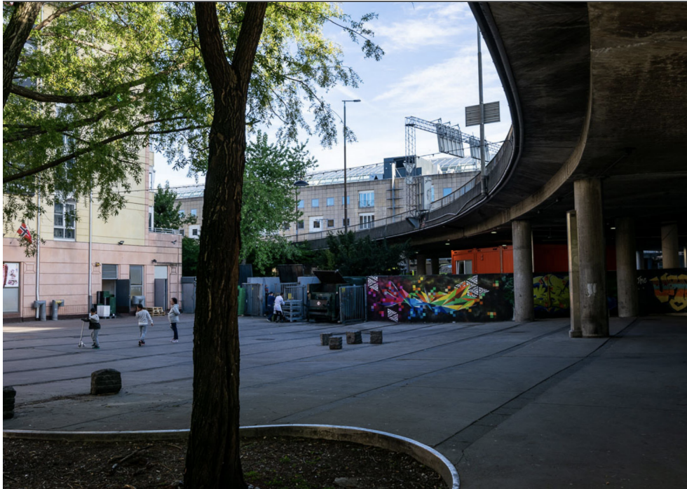
Figur 23: (Galleri Oslo Utvikling og A-LAB, 2021), Under Nylandsveien, sett fra Olafiagangen
