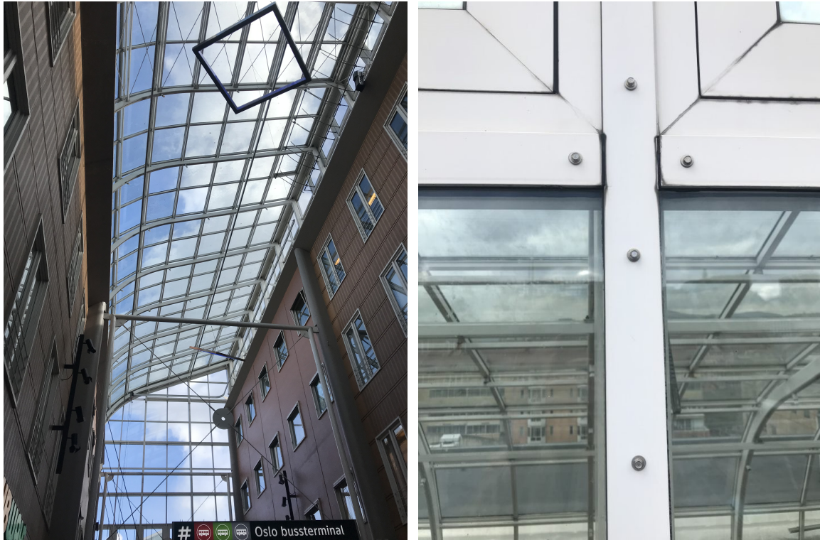
Figur 36: Glasstak over handlegata, innvendig og utvendig, (Tatt på befaring 28. februar 2022 og på befaring 1. april 2022)
