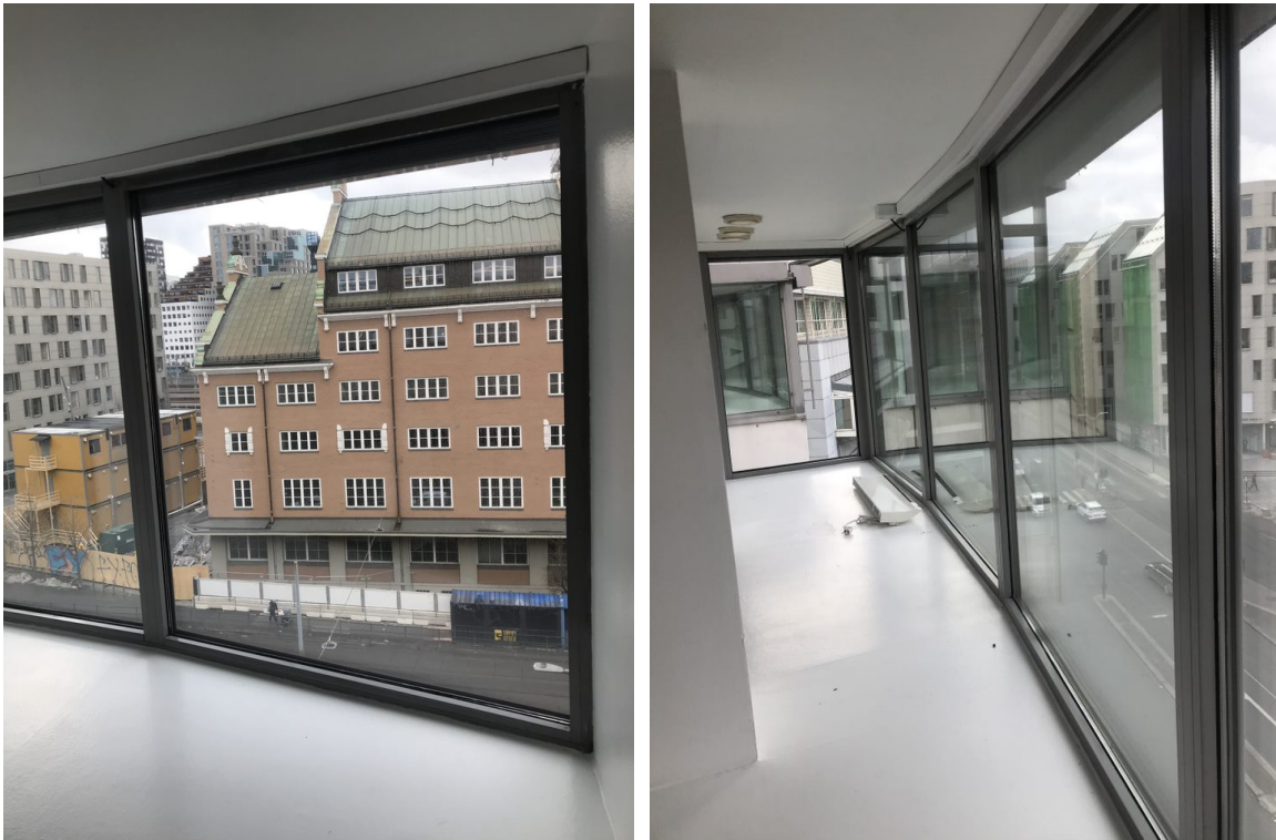
Figur 33: Fast vindu mot Schewigaardsgate, (Tatt på befaring 28. februar 2022)
