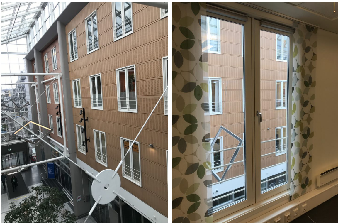
Figur 32: Innvendige vinduer , (Tatt på befaring 28. februar 2022)
