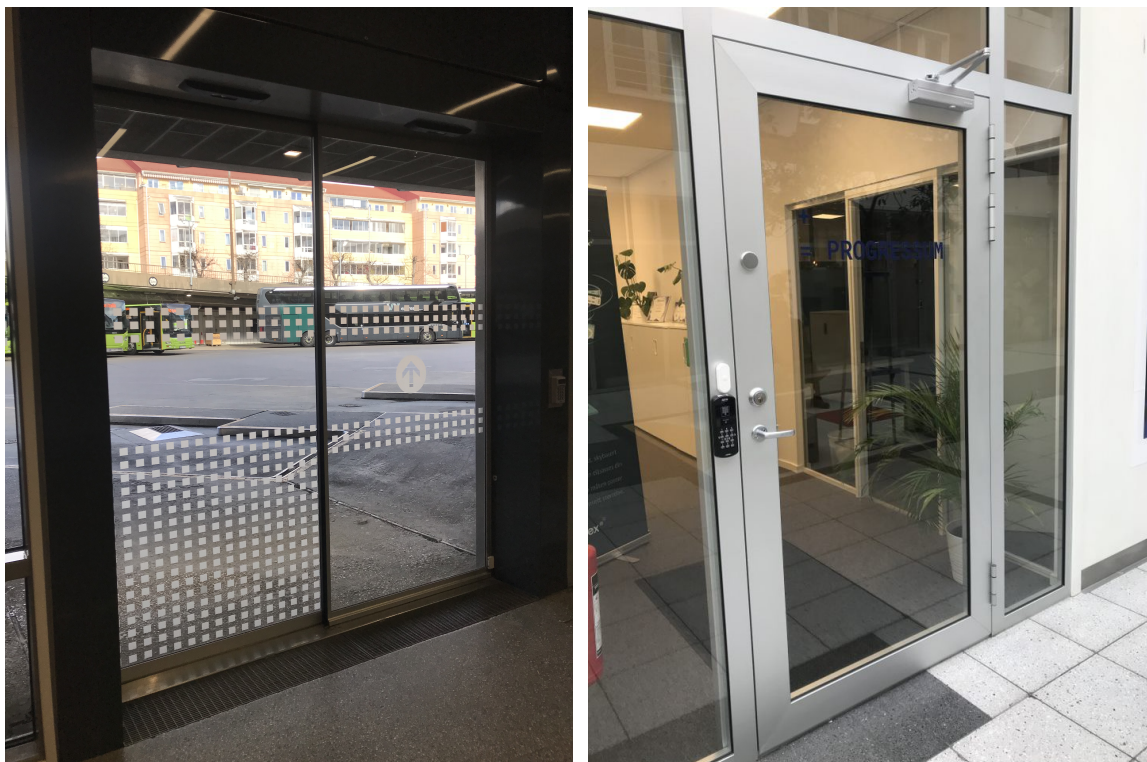
Figur 38: Eksempel på innvendige glassdører i Galleri Oslo, (Tatt på befaring 28. februar 2022 og på befaring 1. april 2022)
