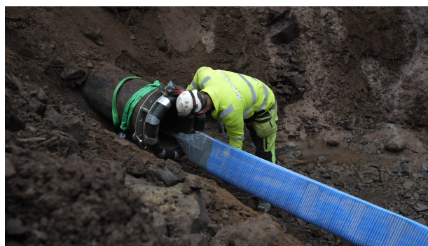
Figur 20: Installering av kevlaramert PE-liner (Primus Line DN500) (Kjeldaas, 2021)
