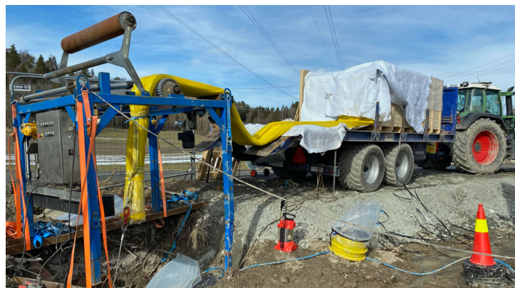
Figur 19: Strømpeføring med glassfiberstrømpe i selvfallsledning (Olimb rørfornying)
