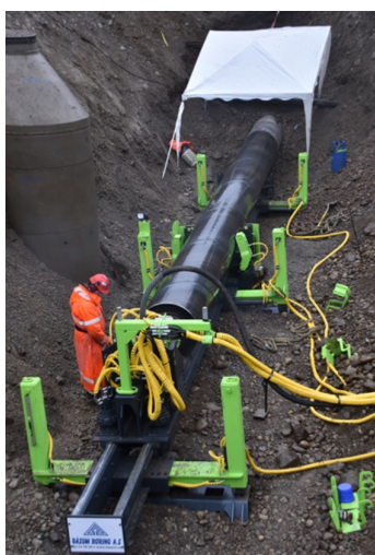
Figur 18: Innkjøring av borerigg ved metoden boring (Båsum Boring)
