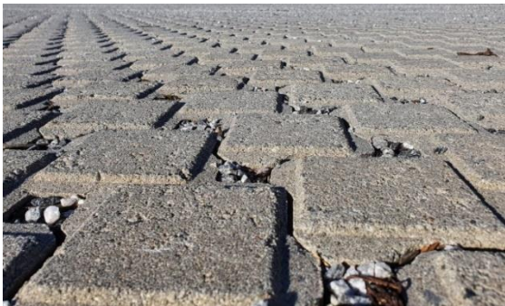
Figur 25 Bildet viser belegningssteiner som har grove kanter (med fas), som ikke er spesielt egnet for områder der hvor universell utforming er et krav. (Foto: Mats Henrik Moen, 07.03.22)
