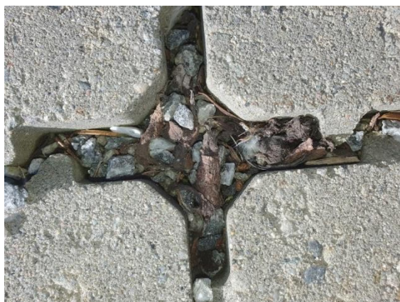
Figur 24 Bark og annen forurensning i fugene i det permeable dekket ved Svinesund transportsenter i Halden. Foto: Mats Henrik Moen, 07.03.2022
