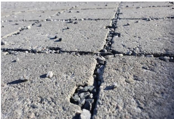
Figur 26 Her vises belegningssteiner som har rettere kanter (uten fas), og er mer egnet til soner der hvor universell utforming er et krav. (Foto: Mats Henrik Moen, 07.03.22)
