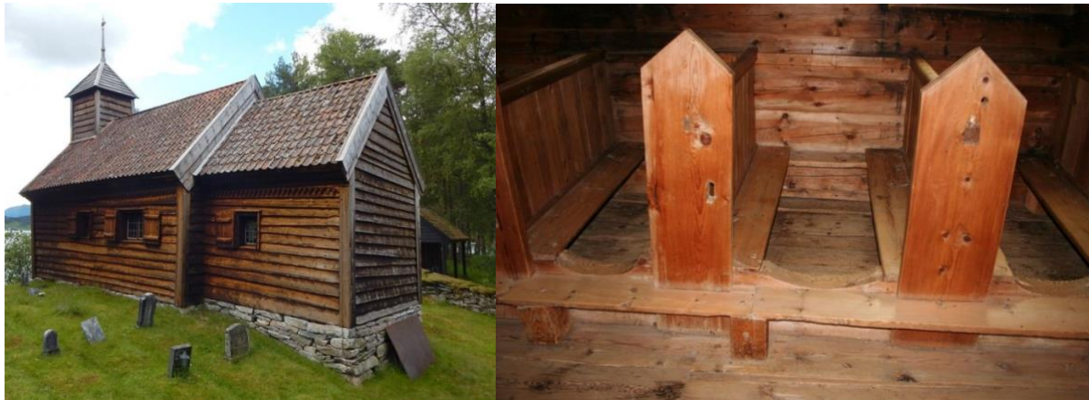
Figur 17. Hestad kapell. Til høyre ombruk av veggtiler og veggsviller fra stavkirken (Norske kirker, u.å.-b)
