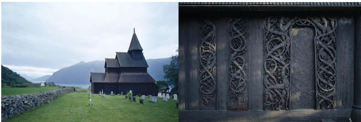
Figur 15. Urnes stavkirke. Den ombrukte nordportalen til høyre (Seip, 2019)
