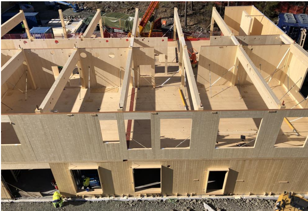
Figur 9: Montasje av MT. Bilde er fra Backe Vestfold Telemark AS og Spinn Arkitekter AS v/James Dodson
