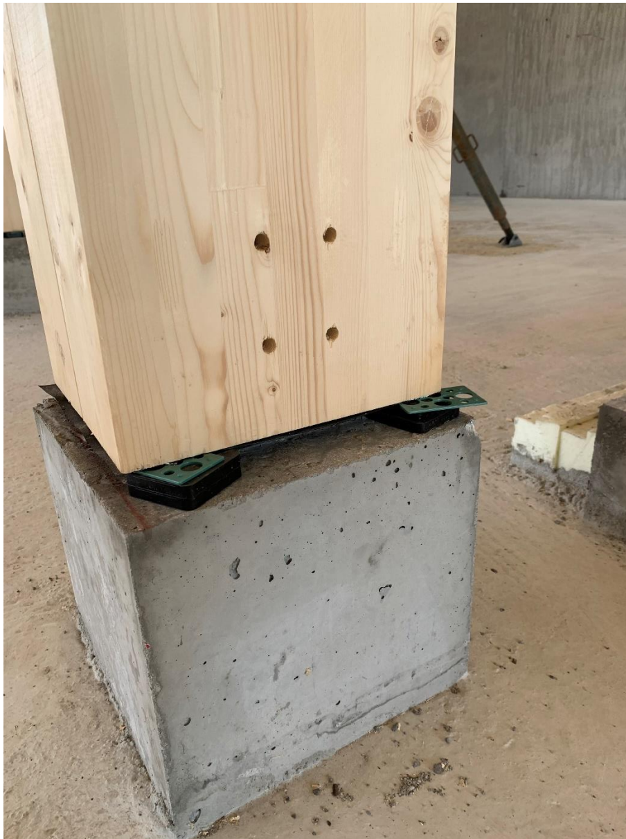
Figur 6: Grensesnittet mellom betong og MT-søyle
