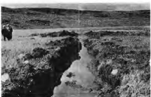
Sprengt kanal på myr. Hevjanåsen, Al.
