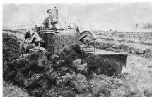
Fylling av grøft med skråstilt skjær på 7-tonns bulldoser. Dalheim, Hadsel 1952.
