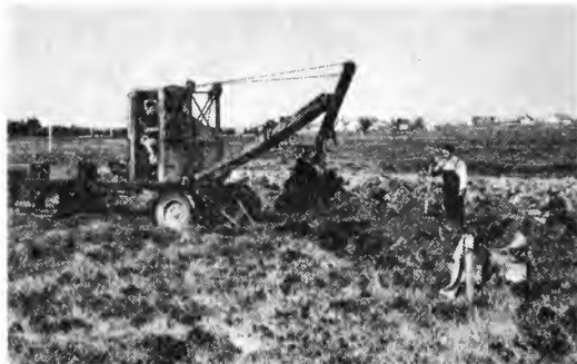
Brøyt III gravemaskin. Opstad, Hå 1953.
