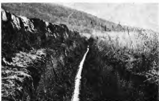
Grøft etter Cuthbertson grøfteplog. Flishaugflotta, Rauland 1952.
