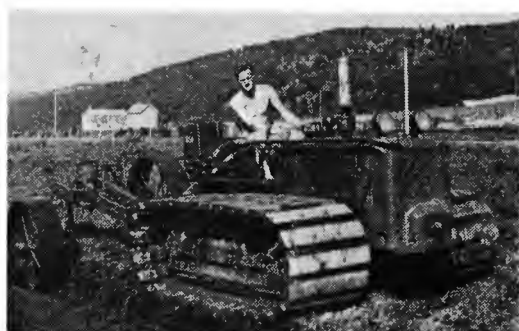
Fiskars plog, 5-tonns beltetraktor med plankebelter. Dalstad, Hadsel 1952.
