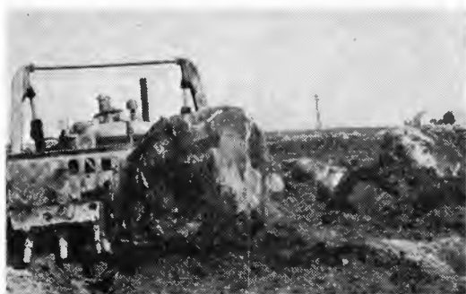
Bulldoser med bred river ved rydding av stor stein. Håland, Hå 1952.
