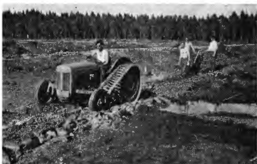
Felleskjøpets grøfteplog. Austmo, Nes, Akershus 1952.
