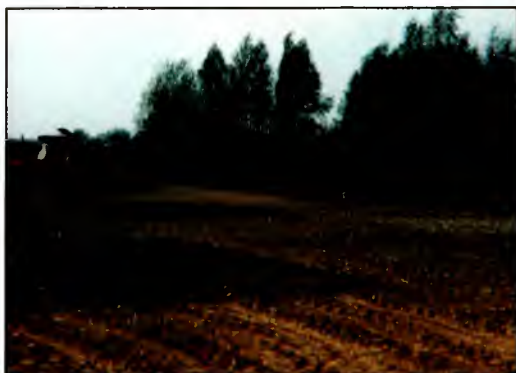
Anlegg av slamfelt våren 1981. Vie s., Stange.
