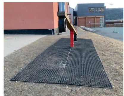
Figur 15: Gressarmeringsmatter brukt som fallunderlag. Foto: Helene Hofmann
