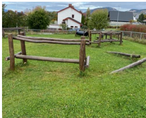
Figur 12: Naturlig gressplen brukt som fallunderlag på Suttetajordet på Lillehammer. Foto: Helene Hofmann
