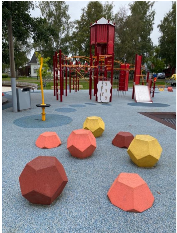
Figur 2: Fallunderlag av plassstøpt gummi på lekeplass i Nordre park på Lillehammer. Foto: Helene Hofmann
