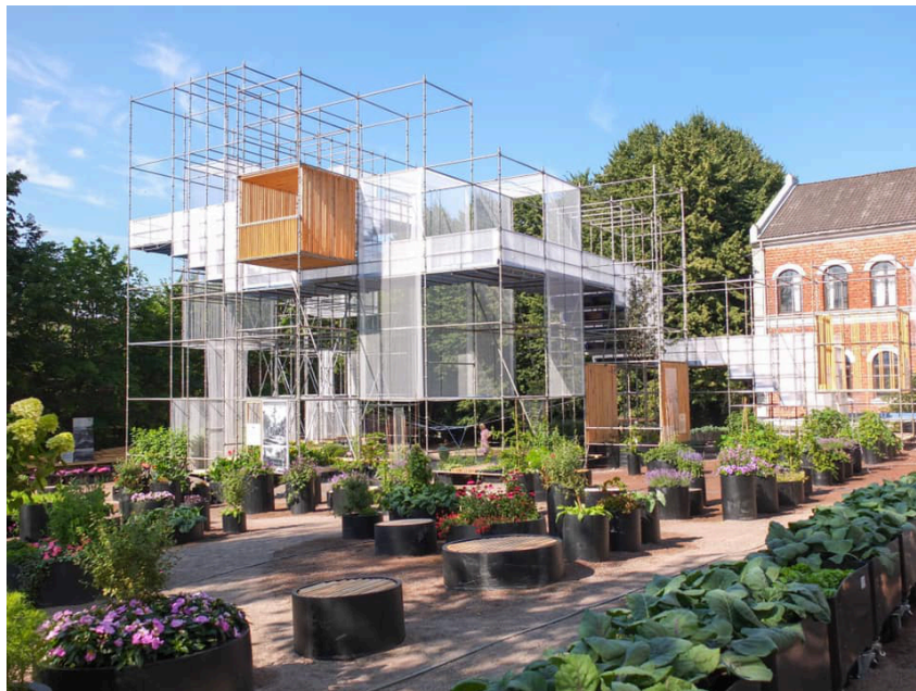
Figur 5: «Akselerator og det midlertige hageanlegget i herregårdshagen under Vi350» (Vi350 - Larvik byjubileum 2021, 2021).
