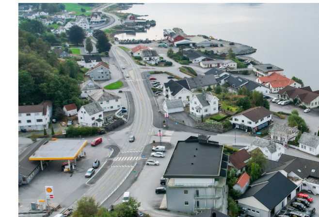
2 Dronefoto. Krysset E134/Sjoargata. Sjoargata. Det er i dag tre tilkomstveier ned til sentrum, hhv. gjennom Mulagata, Sjoargata og Dreganesvegen.
