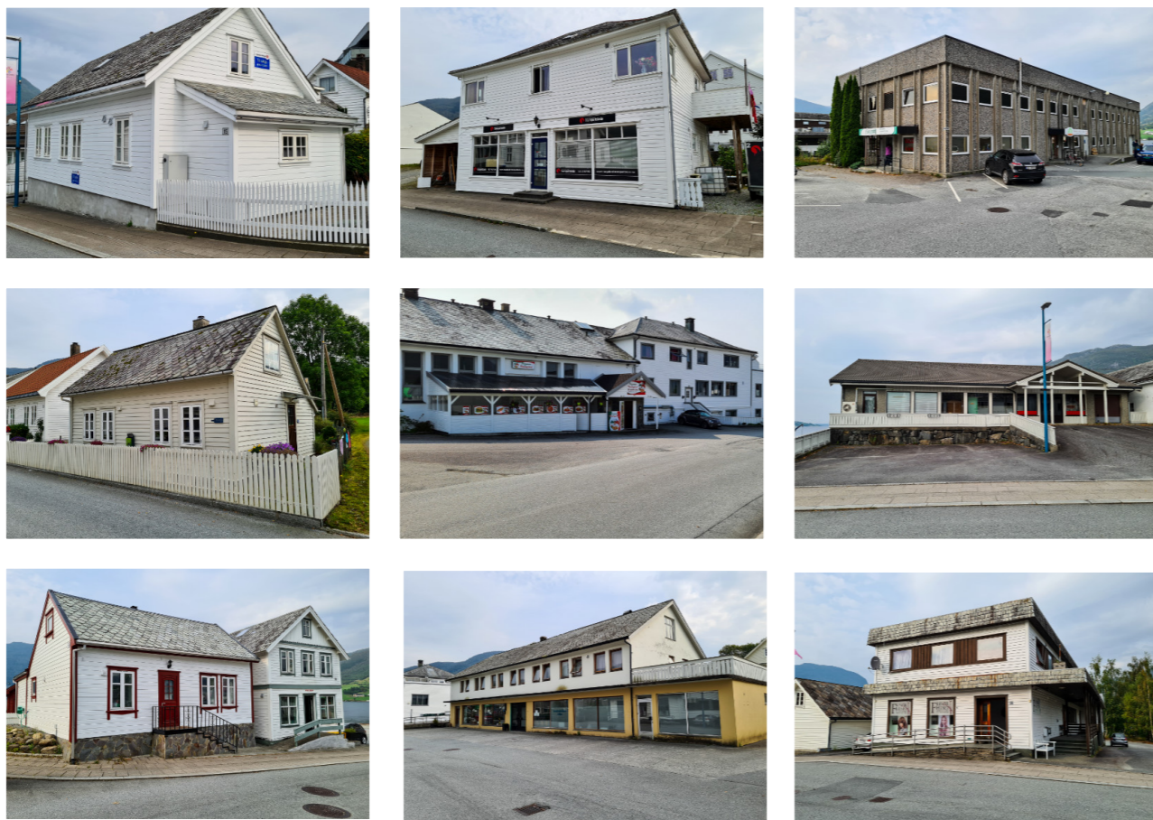
Figur 3.19: Bygningstypologier i Sjoargata. Eldre, mer private hus til venstre, nyere bygg med dels aktive fasader i midten, næringsaktige bygg til høyre
