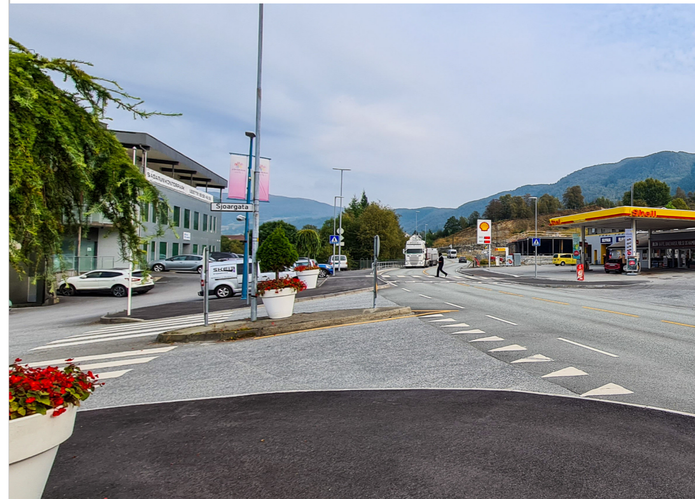
Figur 3.24: Det er i dag svak kobling for gående mellom Sjoargata (utløp til venstre) og nye Eiodalen handelssenter (under konstruksjon bak Shell-stasjonen). Sett fra vestre utløp av Sjoargata.
