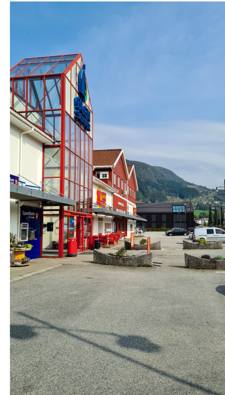
20 Asfalten fra parkeringsplassen strekker seg tett inntil fasadene på Ølen senter
