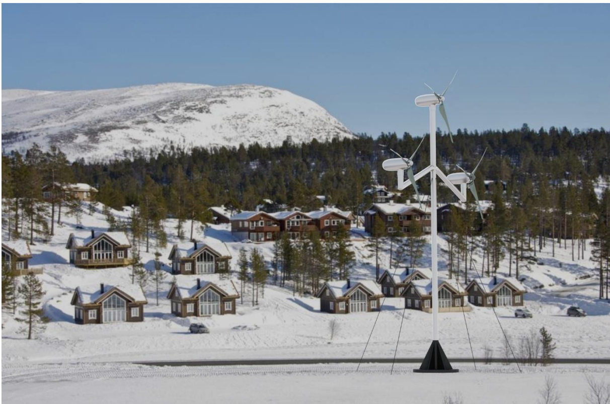
Figur 15.4: Vindturbinen står i et hytteområde i fjellandskap og forsyner hyttefeltet med elektrisitet. Turbinen er forankret med barduner til bakken.
