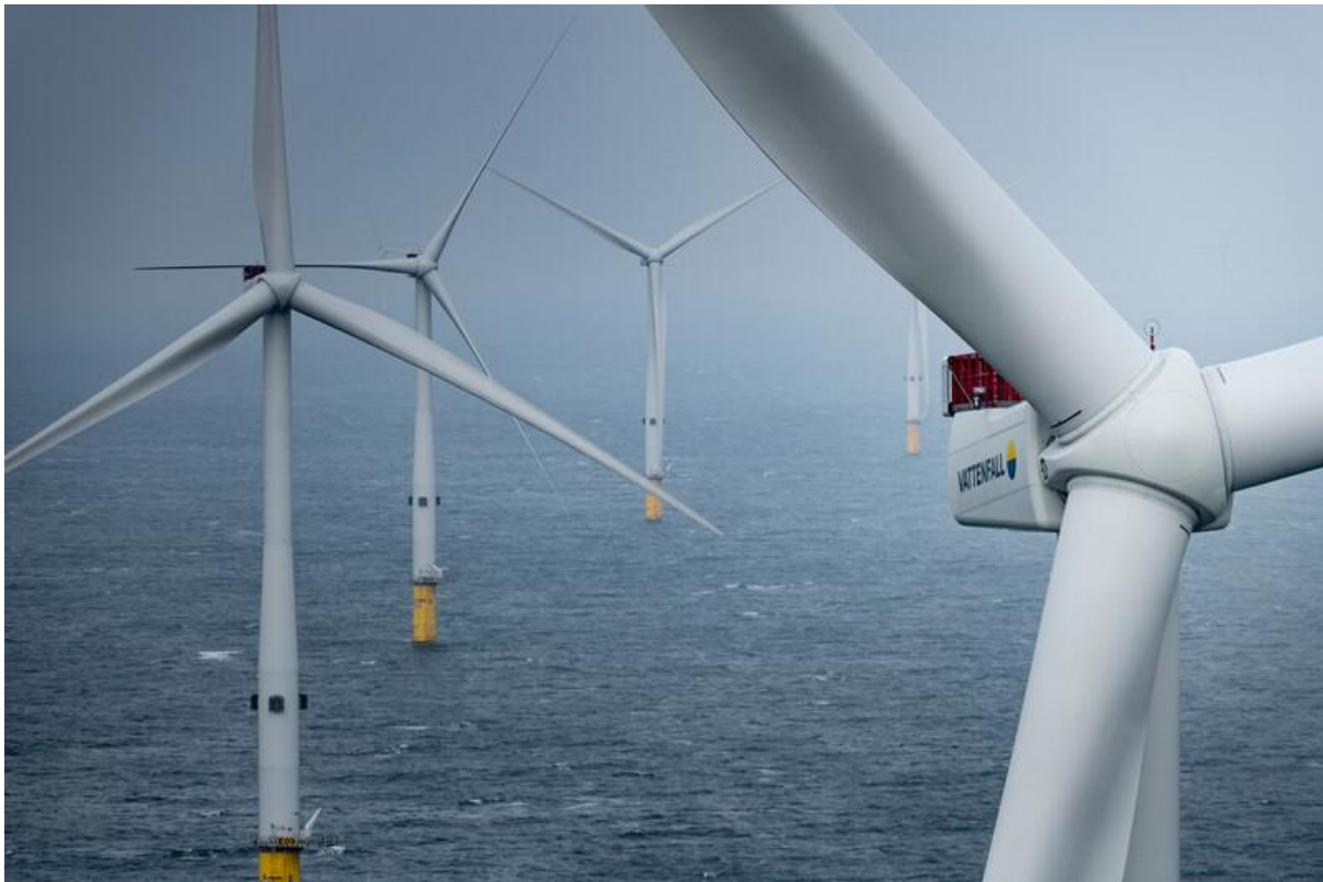
Figur 1.6: Bilde av vindturbinen Vestas V164-8.4MW i vindkraftverket Horns Rev 3, Danmark [11]. Kraftverket har levert elektrisitet siden desember 2018.
