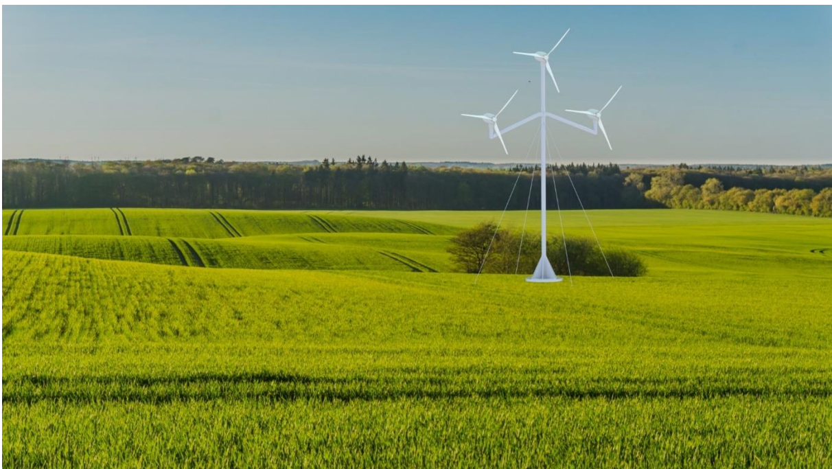
Figur 15.6: Vindturbinen står montert med tre moduler ute på et jorde. Turbinen forsyner gården med elektrisitet, og har tilgang på gode vindressurser på grunn av åpent og flatt landskap.
