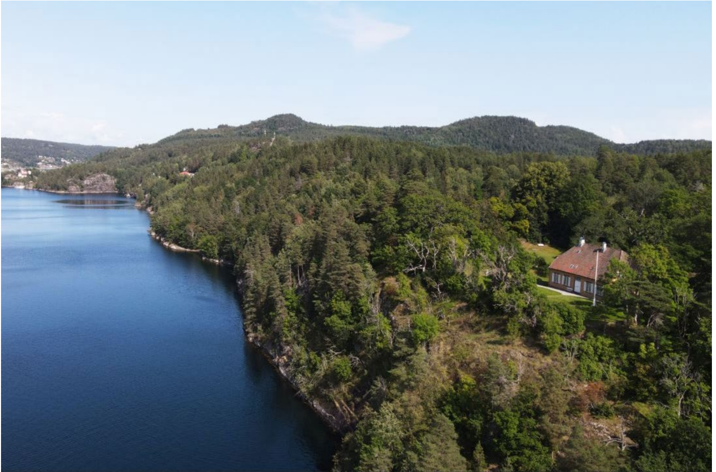
Dronebilde av Berg, hovedhuset til høyre i bildet.
