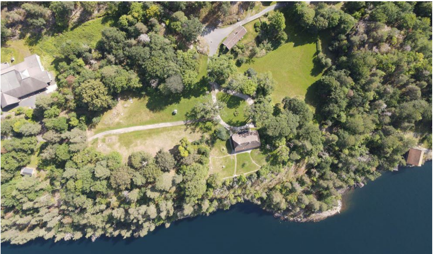
Parken på Berg. Administrasjonsbygget til venstre og hovedhuset sentralt i bildet.
