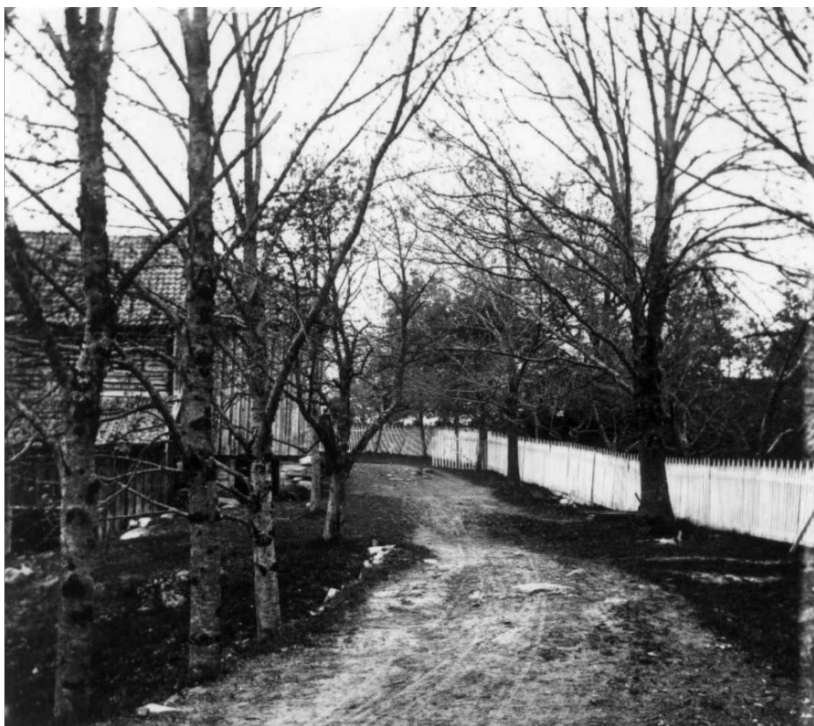
Figur 3.18: Alléen opp mot hovedhuset. Berg- Kragerø Museum, (ca 1840-1860).
