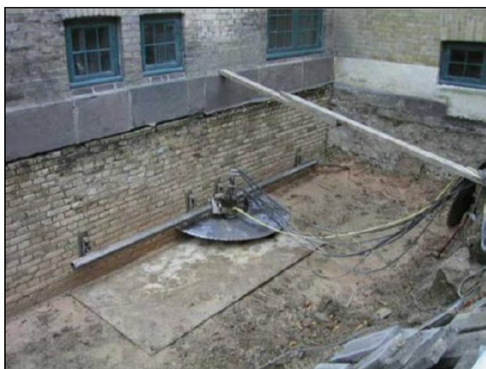
Figur 29: Skjæringsprosessen som foregår automatisk med elektrisk sag. (Sintef, Utbedring av fuktskadede kjelleryttervegger)
