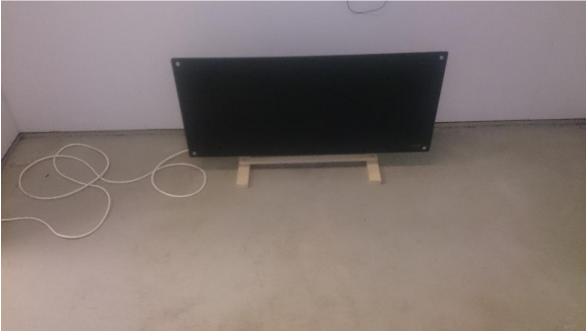
Figur 12: Panelovn med glassoverflate plassert midt i rommet. Ovnene er plassert på et stativ da det ikke var mulig å montere den på veggen.
