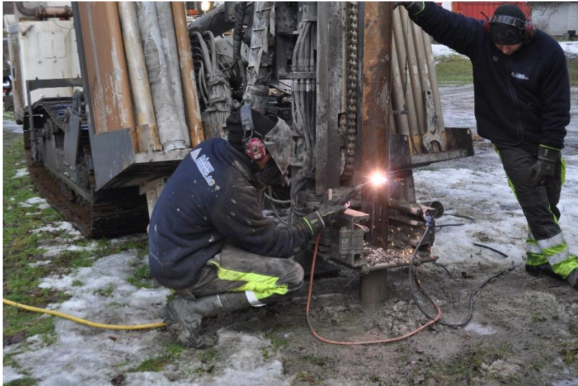
Figur 29: To føringsrør sveises sammen.
