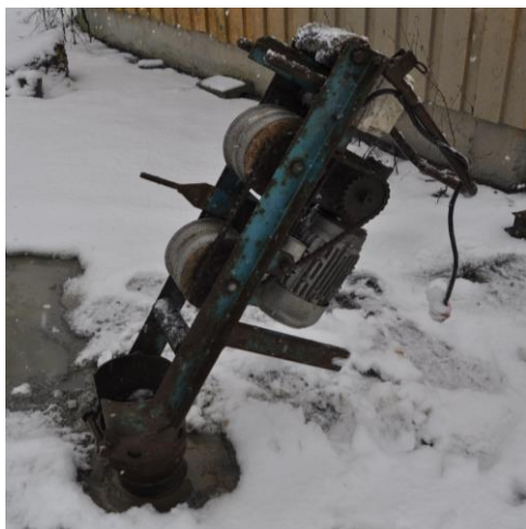
Figur 34: Kollektormatereren benyttet for å senke U-rørskollektoren i borehullet.
