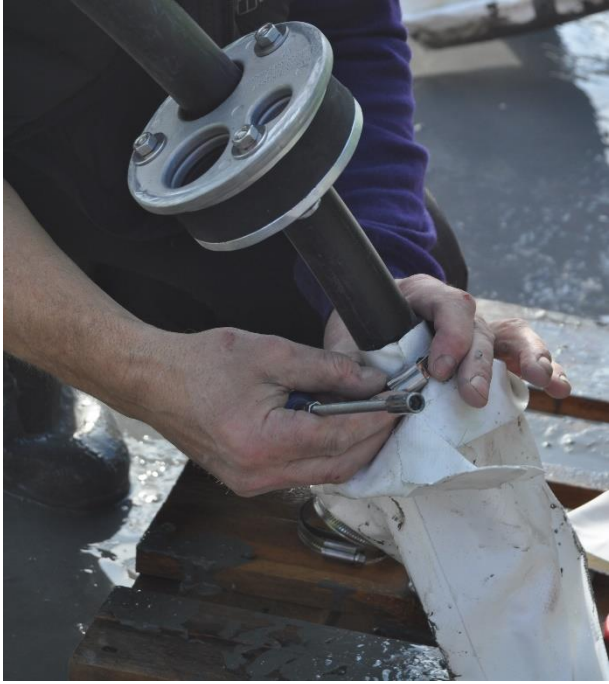
Figur 40: Et rør ble klipset fast i det indre røret i Abbakonda-kollektoren.
