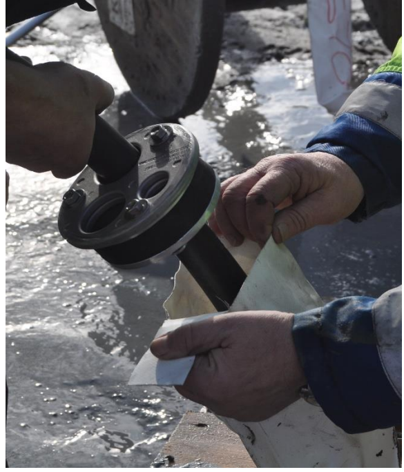
Figur 41: Det ytre rør til Abbakonda-kollektoren ble tredd utenpå kollektorlokket.
