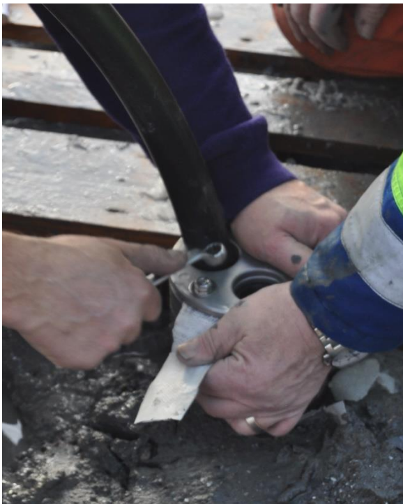
Figur 42: Et kollektorlokk ble påmontert føringsrøret. Det indre rør går via det sorte plastrør.
