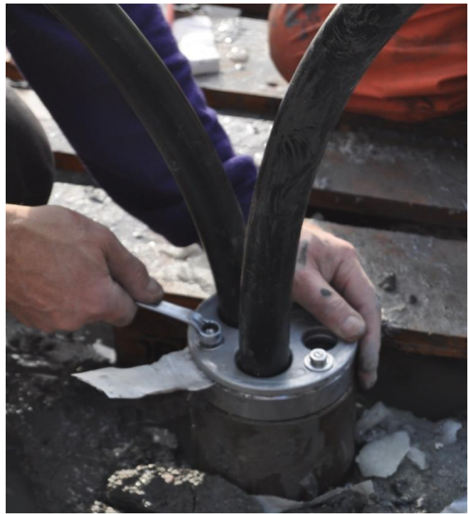
Figur 43: Et plastrør ble montert til det ytre rør.
