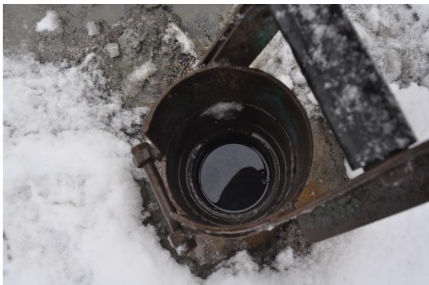
Figur 32: Vannspeilet i borehull 1 sett ovenfra.
