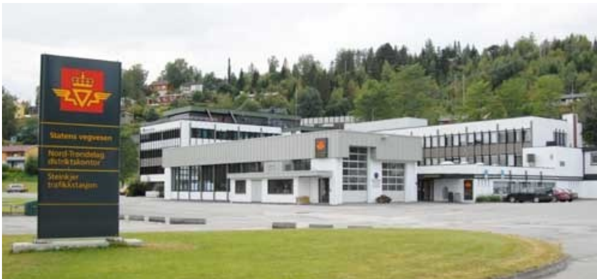
Vegkontoret i Nord-Trøndelag (Foto: Morten Stene, 2006)
