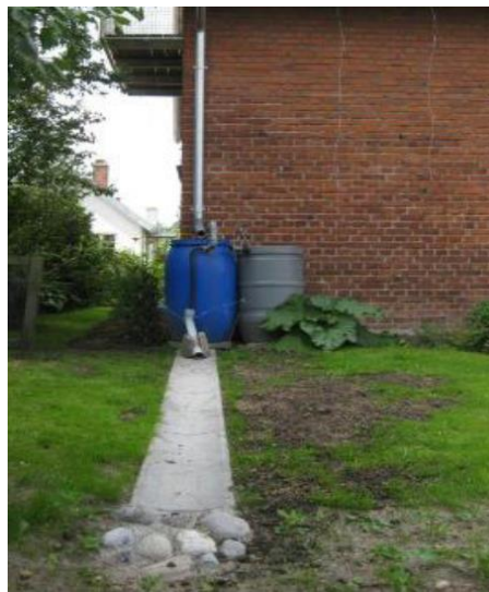
Figur 2.8.15. Figuren viser en regntønne som slipper vannet kontrollert videre til en plen. Foto: Ødegård (Vista Analyse AS / COWI, 2015).
