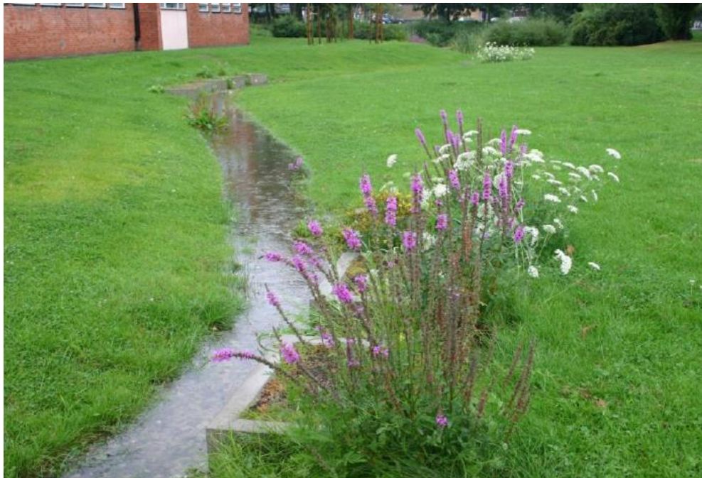
Figur 2.8.7. Figuren viser en typisk gresskledd vannveg fra Augustenborg/Malmø (Fotograf: T. Leidstedt).
