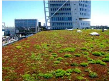
Figur 2.8.1. Bilde til venstre viser rådhuset i Chicago med grønt tak (National Geographic Norge, 2015) og bilde til høyre viser et sedumtak i Malmø (BYGGBASEN, 2015).
