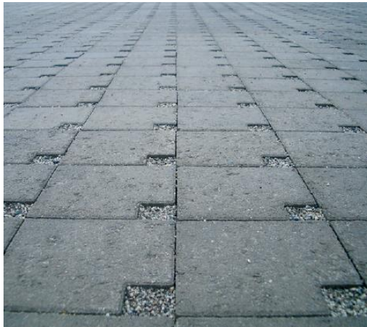
Figur 2.8.9. Belegningstein med 12 % permeabelt areal (Multiblokk, 2015).
