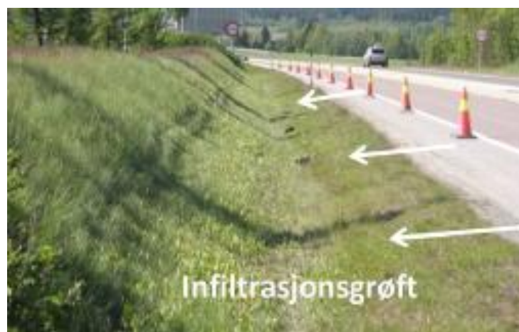
Figur 2.8.10. Bilde av infiltrasjonsgrøft med gress langs E6, ved Minnesund (COWI, 2013).
