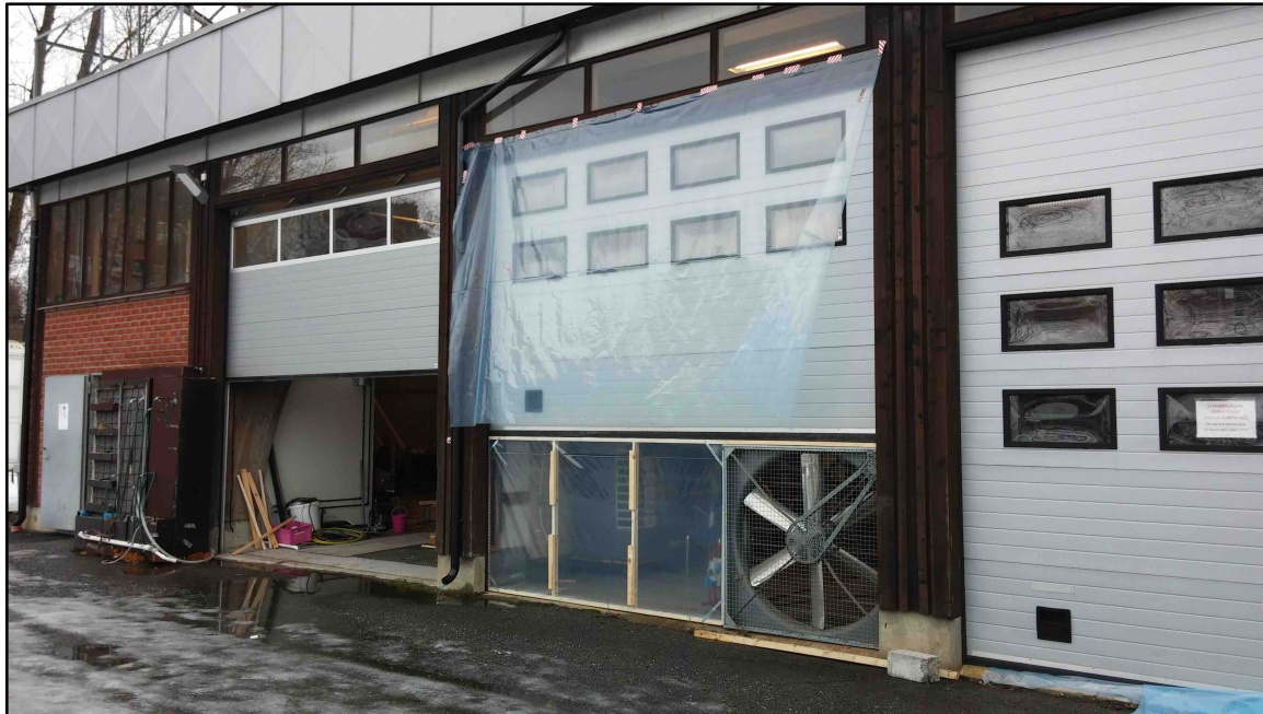
Figur 3.10 Bilde tatt under forberedelser til trykktest på fløy 4. Viften og den provisoriske vegg er installert (Foto: Henrik Fluge Iden)
