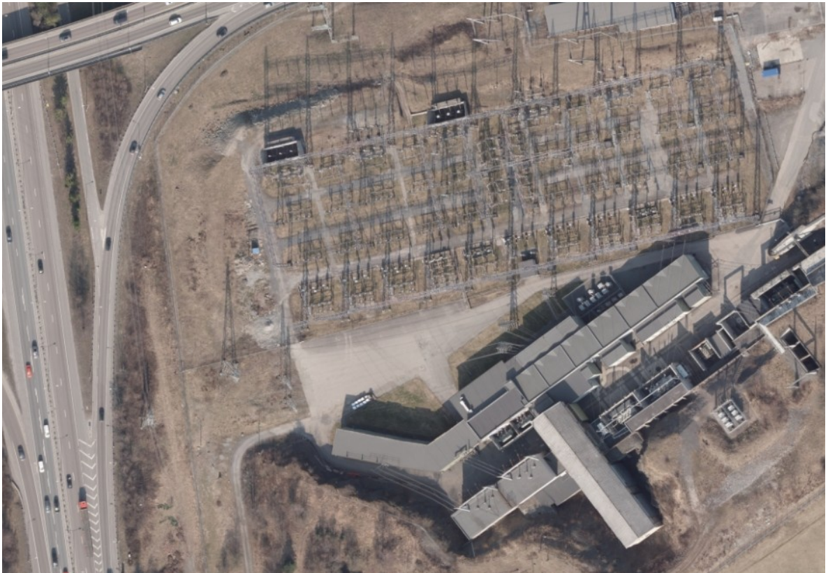
Figur 3.4: Ulven transformatorstasjon. Foto: Kartutsnitt fra Norge i Bilder.
