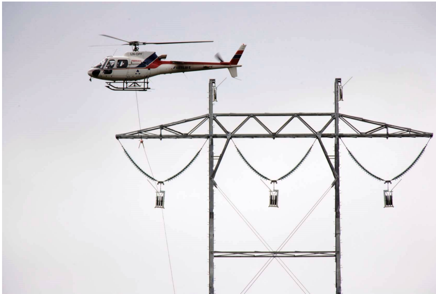
Figur 4.4: Pilotline kjøres ut og legges i blokka på den ene ytterfasen. Foto: Statnett.
