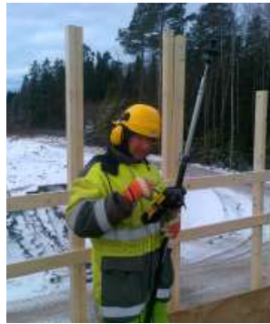
Figur 4.3: En landmåler med bærbar GNSS og en feltcomputer for registrering av målepunkter. Foto: Geomatikk Survey.
