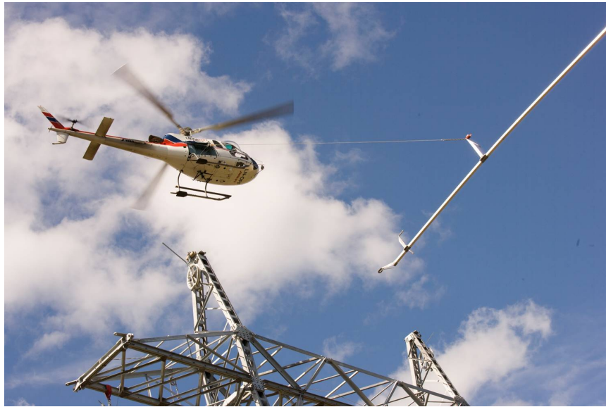
Figur 4.5: Pilotline for midtfasen tres igjennom masten. Foto: Statnett.
