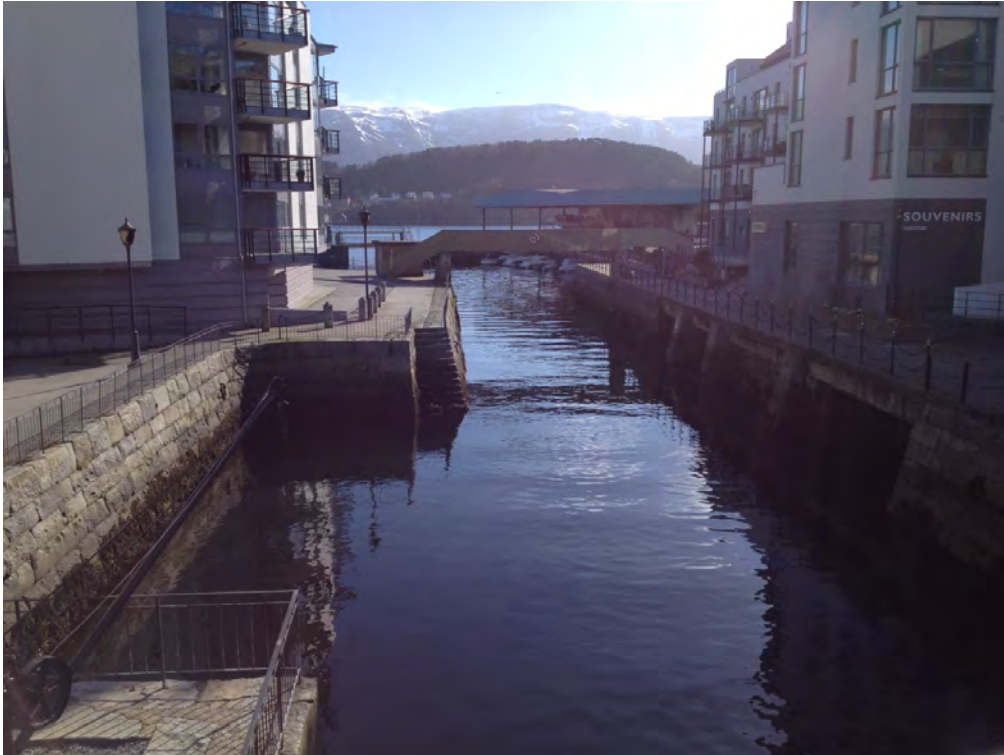
Bilde 3.15: Utsikt fra Hellebroa sørover mot havnen, gangbro over sundet kan skimtes midt i bildet.
