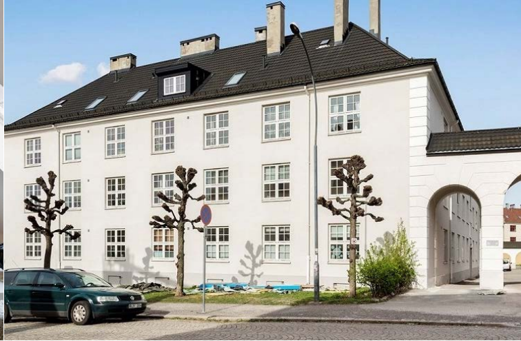
Figur 26 viser innredning av ny loftsleilighet i Rosenhoffgata 7. Hentet fra https://eiendomsverdi.no/app/appSingleEstate.aspx (krever innlogging)
