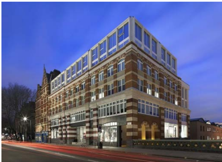
Figur 7: Eksempel på påbygg i London: "The Rosebery". (Foto: Buckley Grey Yeoman). Hentet fra: http://www.buckleygrayyeoman.com/project/the-rosebery/
