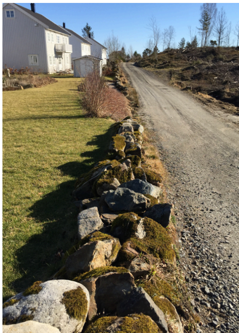
Figur 30: Steingjerdet mellom boligfeltet og veien inn til hyttefeltet (Kilde: A. T., 2015)
