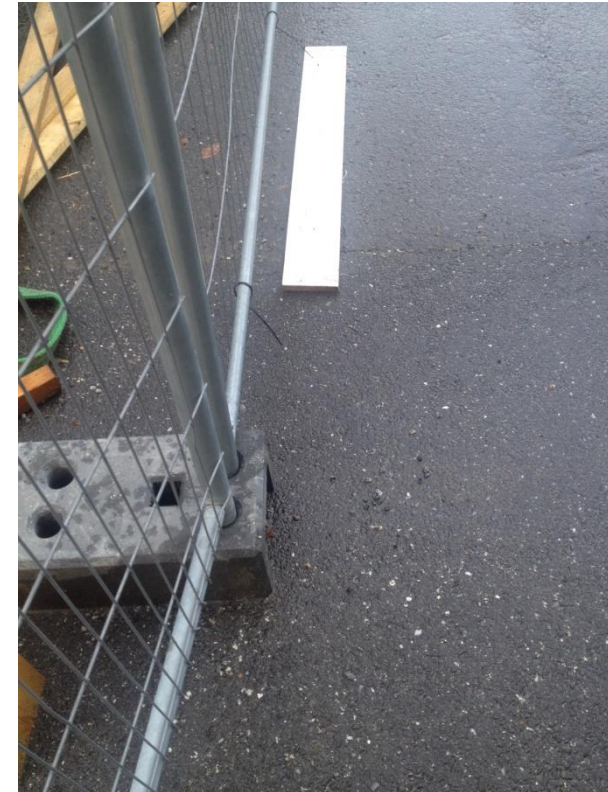
Figur 20 Betongfot som ikke stikker inn i veien.
