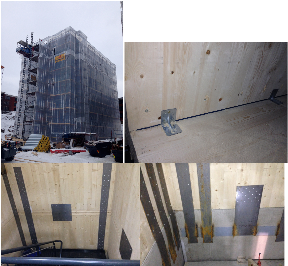
Figur 1.2 Uppe till vänster: Palisaden under uppförande. Uppe till höger: Helgängade skruvar och vinkelbeslag med skruvar mellan element tänkt att ta horisontella krafter och sträckkrafter. Nedtill vänster: Plåt med skruvar mellan element tänkt att föra horisontella krafter vidare och även sträckkrafter. Nedtill höger: Stålplåtar mellan våningar, förankrade och insvetsade i grunden och tänkta att ta sträckkrafter.
